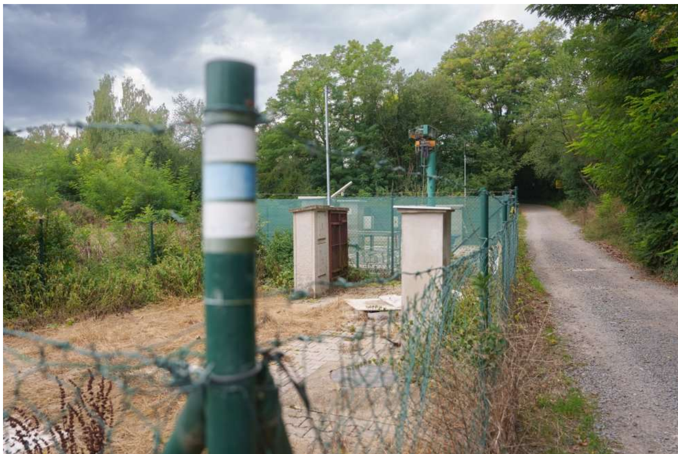
Stávající čistička ve Stávanicích. Foto: Jakub Plíhal, Deník N
